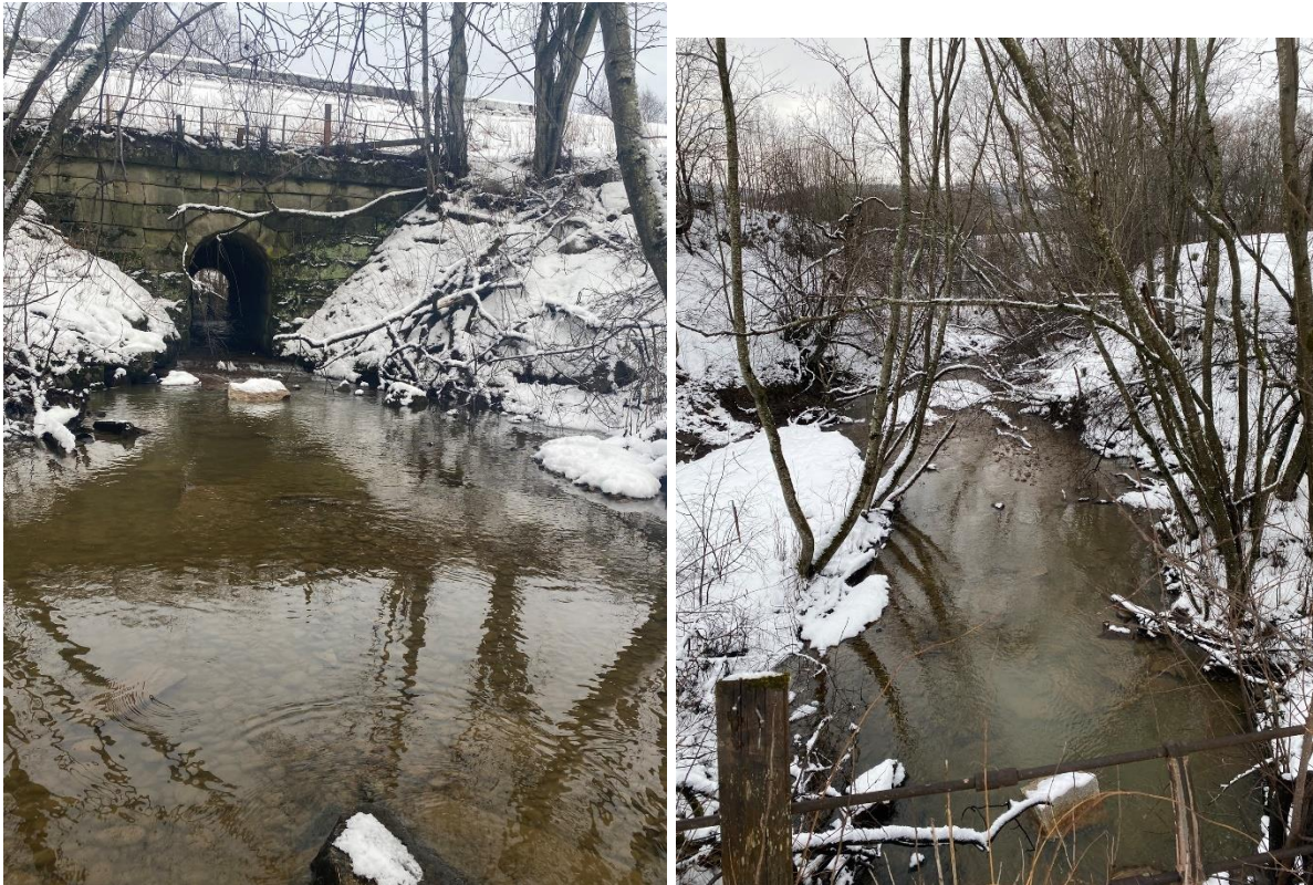
Figur 4-11 Naturlig terskel ca. 30-40 meter nedstrøms jernbanekulvert. Venstre bilde: Bilde tatt fra terskel og opp mot kulvert. Høyre bilde: Bilde tatt fra oppå kulvert/jordbruksvei og nedstrøms.
