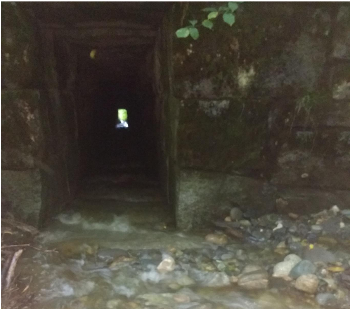
Figur 4-28 Eksisterende steinkulvert for Stygårdsbekken.
