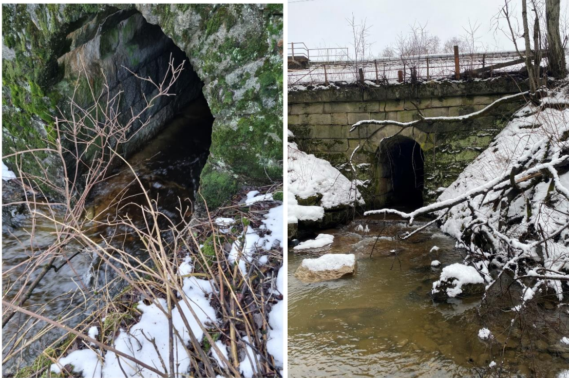
Figur 4-10 Bilder av jernbanekulvert. Venstre side: Oppstrøms. Høyre side: Nedstrøms.
